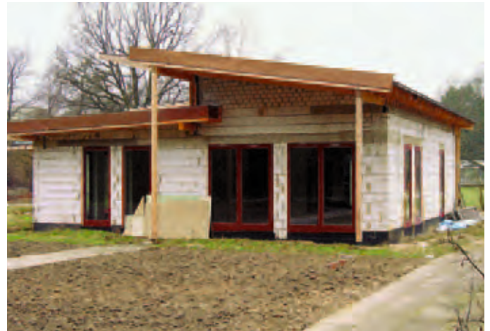
Rohbau des neuen Bienenhauses von Osten gesehen, 2003
