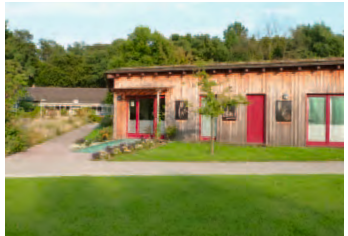
Neues Bienenhaus, 2004; im Hintergrund das alte Schulhaus
