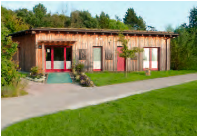
Die Eingangsfront des neuen Bienenhauses
