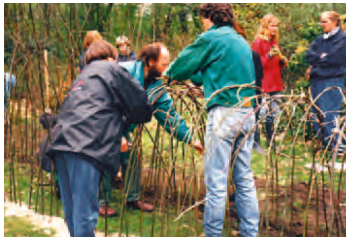
Bau eines Weidentunnels
