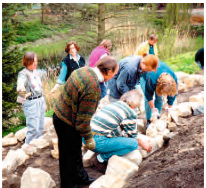
Hier entsteht eine Trockenmauer
